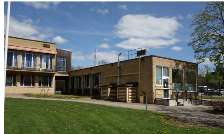
Den lägre bankdelen med de öppna fönstren som markerar en vestibul.
