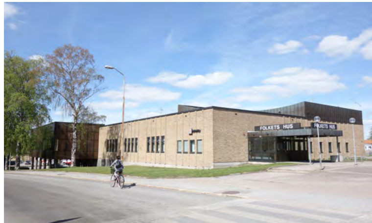
Byggnadens funktioner avspeglas i det tredelade uttrycket; glas- och stålparti, massiv tegelfasad och upphöjt scentak.
