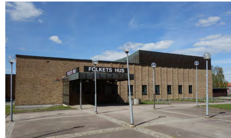
Den stängda fasaden mot öster.
