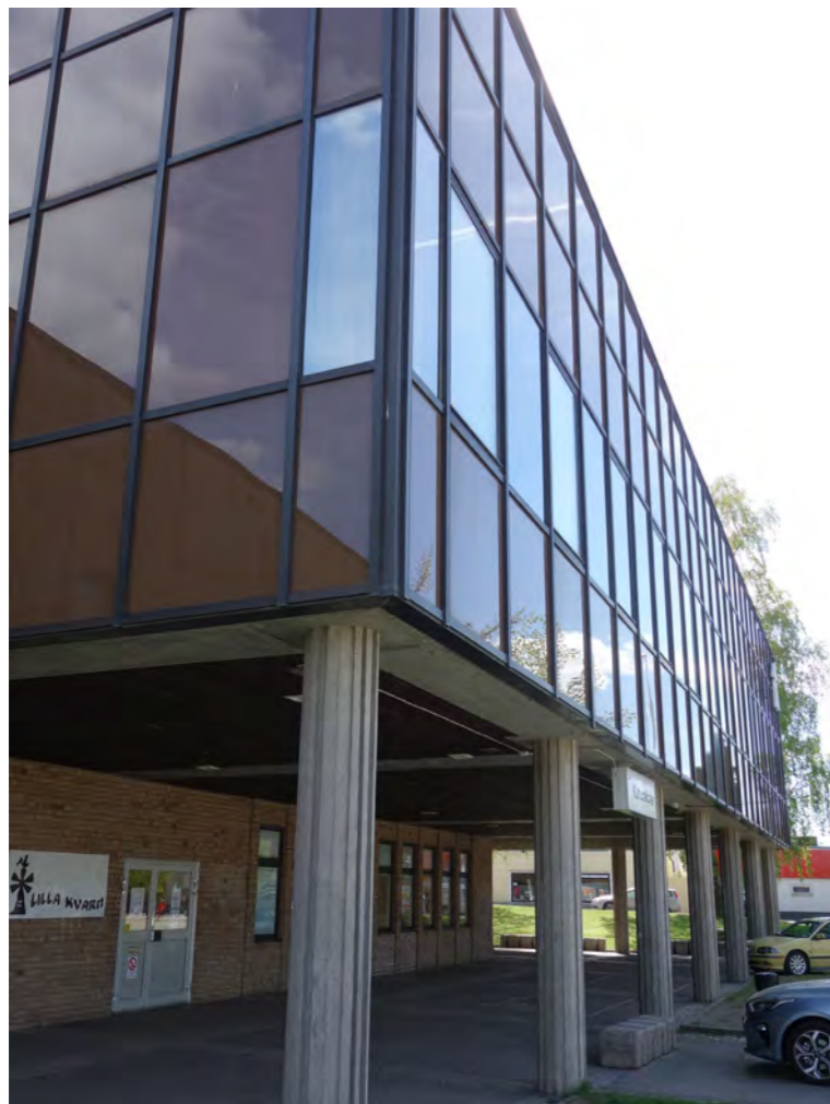
Glas- och stålpartiet uppburet av räfflade betongpelare.
