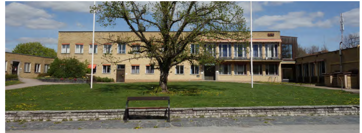
Kommunalhusets byggnad och flyglar inramar en grönskande park med avgränsande stödmurar samt markbeläggning av Grythytteskiffer.
