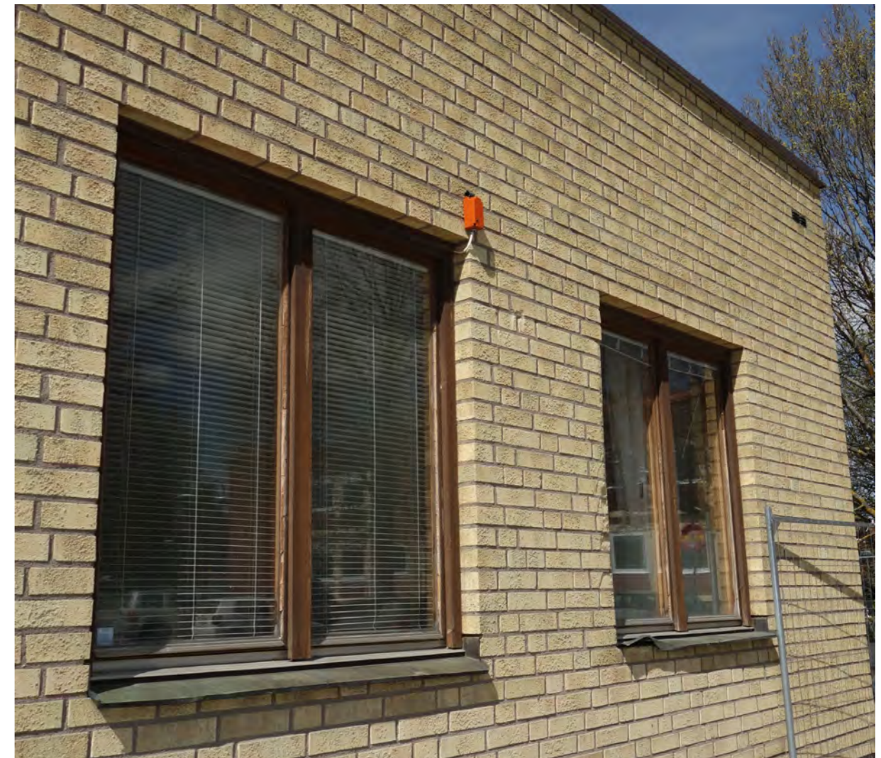
Ovan: Den ursprungliga byggnadens tvåluftsfönster av ek och fasadmaterial i ljusgult Rödbotegel är bevarat. Det är oklart om fönstersnickerier ursprungligen varit brunbetsade som i bankdelen ovan, eller vitmålade som resterande fönster i byggnaden.
